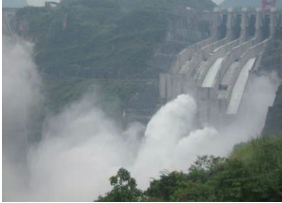
湖北清江水布垭电站(4×460MW) Hubei ShuiBuyaHydropower Station (4×460MW)
