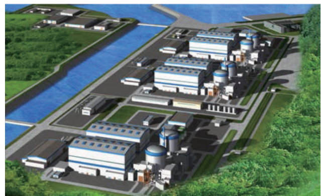
阳江核电站(4×1100MW)
